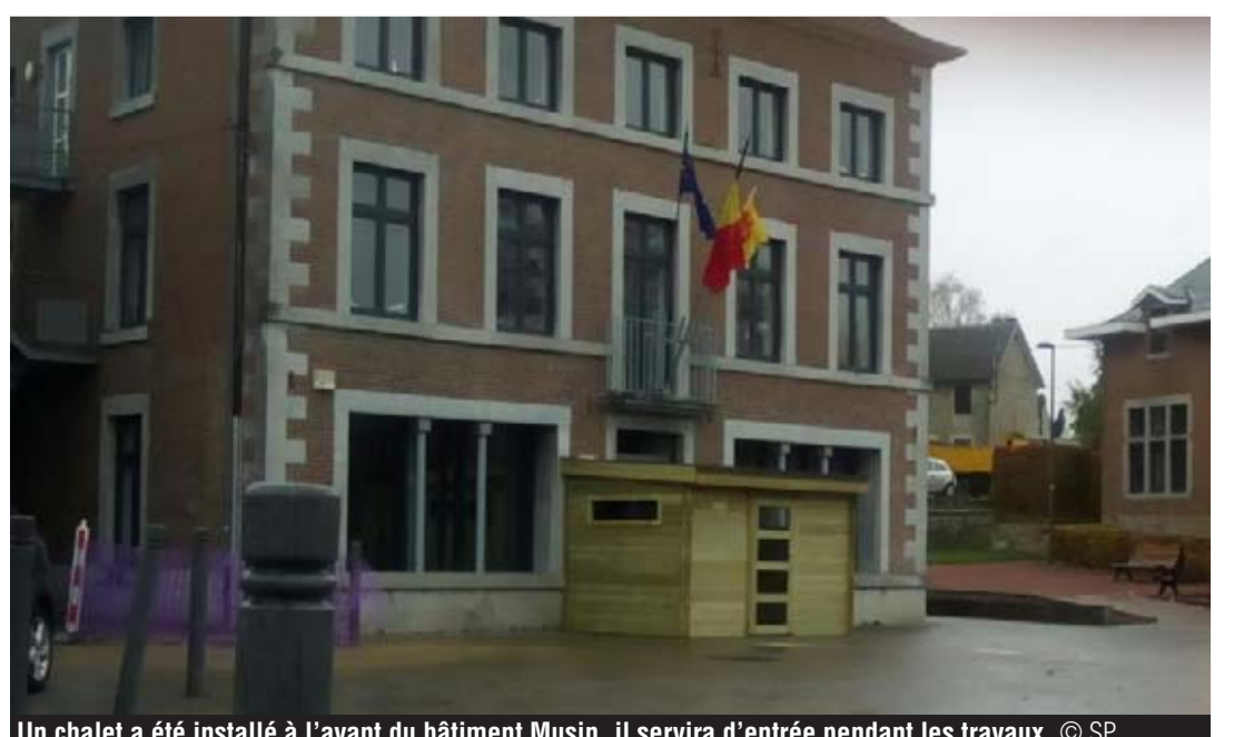
Un chalet a été installé à l'avant du bâtiment Musin, il servira d'entrée pendant les travaux. © SP
